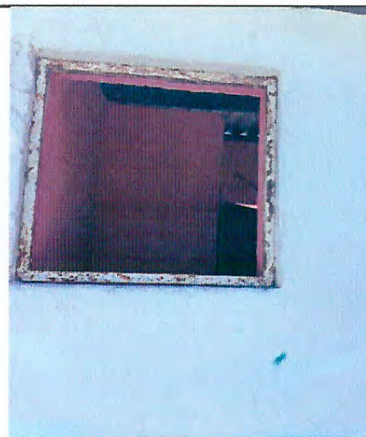
Foto 4: Mejoramiento de ventanas de baños.
