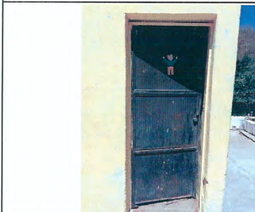
Foto 3: Mejoramiento de puertas de baños.
