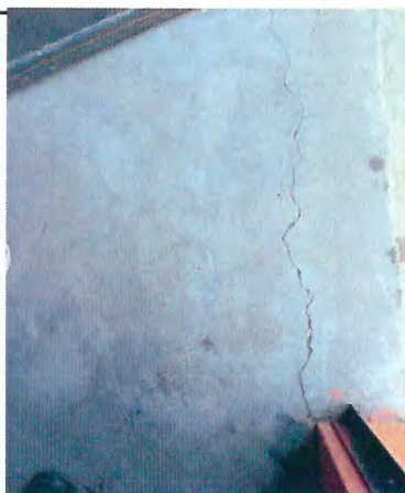
Foto 3: Mejoramiento de piso de aula No.4
