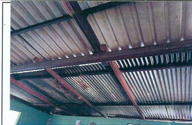
Foto 1: Mejoramiento de techo de aula.
