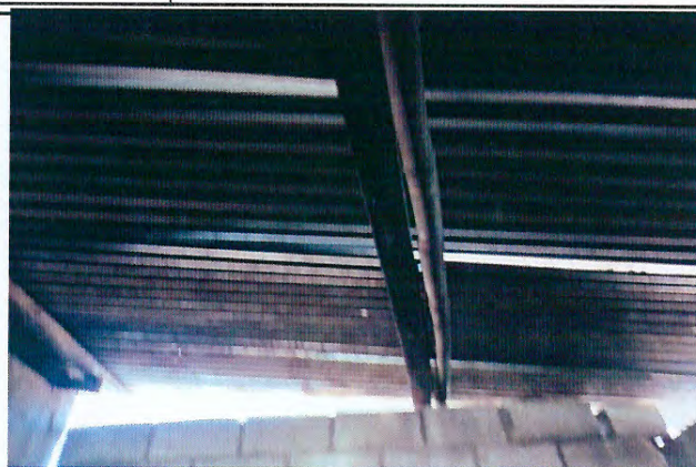
Foto 2: Mejoramiento de techo de cocina.
