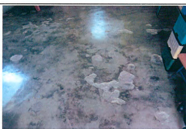
Foto 4: Mejoramiento de piso de bodega
